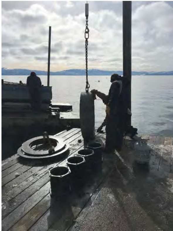
Fig. 2 - Placing temporary manhole risers.
