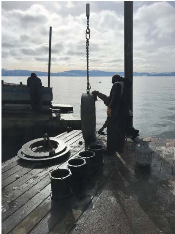
Fig. 2 - Placing temporary manhole risers.
